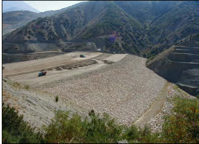
Şekil 4. 7. Darıdere Barajının genel görünümü
